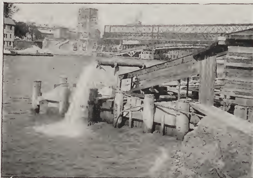
LES ABORDS DU PONT ALEXANDRE. — La pompe d'épuisement.
